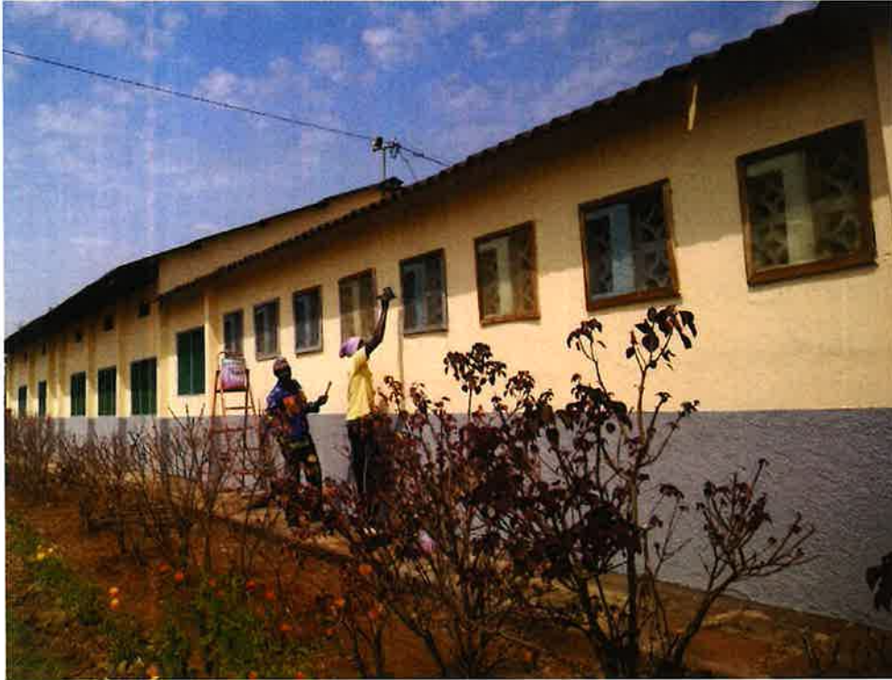
Aplicação de redes de metal anti-mosquitos → antes as janelas estavam todas esburacadas e repletas de ninhos de vespas, morcegos
