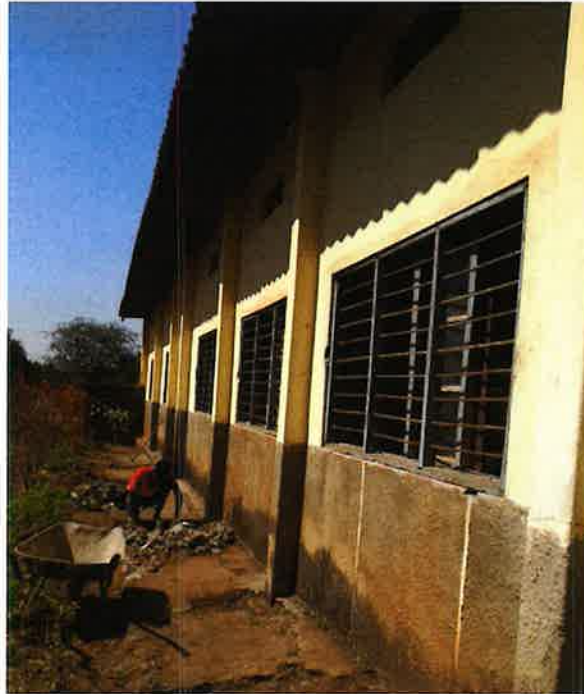
Renovação da calçada que quase comprometia a fundação da casa
